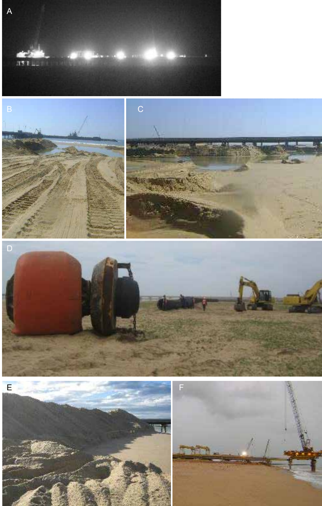
Figura 11: Atividades geradoras de impactos às tartarugas marinhas durante a realização de obras costeiras e marinhas. A – Fotopoluição; B – Trânsito de veículos; C – Movimentação de sedimentos/aterros; D – Movimentação de máquinas e equipamentos; E – Acreção de areia na praia/aterros; F – Construção de ponte de acesso portuária, cravamento de estacas no leito marinho e geração de ruídos e luz. Fonte: Banco de imagens do Centro TAMAR/ICMBio.
